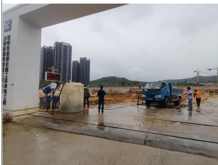
西侧颐峰名庭施工场地
