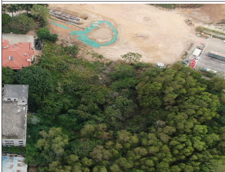
北侧在建道路
