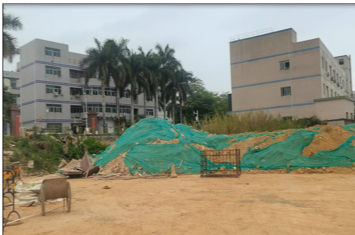
北侧龙坪路施工场地
