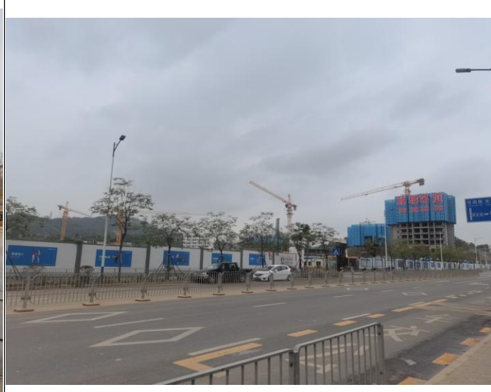
西侧道路龙凤路及颐璟名庭、颐峰名庭施工场地
