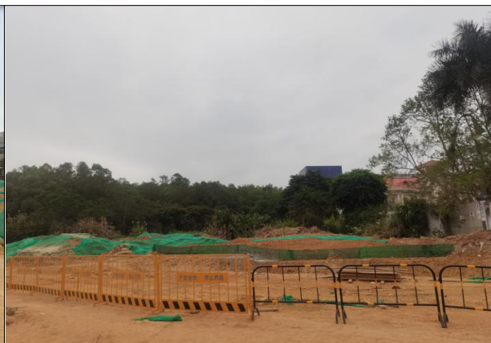
北侧在建道路
